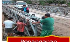
Penanganan Jembatan Bailey
