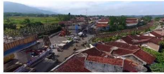
Perakitan Jembatan Bailey P3 - P4
